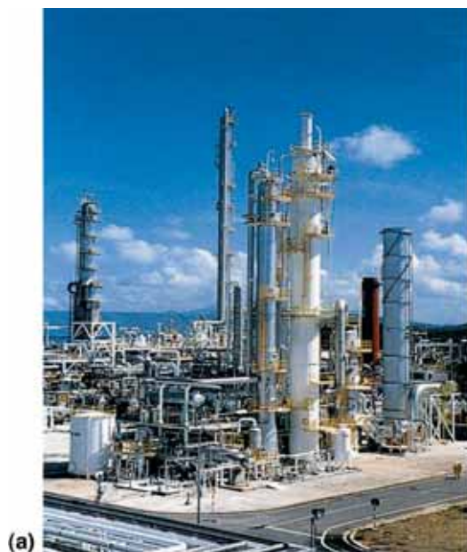
Gráfico RT-4. a) Captación de \text{CO}_2 posterior a la combustión en una planta de Malasia. Esta planta utiliza un proceso de absorción química para separar 0,2 Mt de \text{CO}_2 al año del flujo de gas de combustión de una central eléctrica alimentada por gas para la producción de urea. (Por gentileza de Mitsubishi Heavy Industries). b) Captación de \text{CO}_2 previa a la combustión en una planta de gasificación de carbón en Dakota del Norte, Estados Unidos. Esta planta utiliza un proceso de solvente físico para separar 3,3 Mt de \text{CO}_2 al año de un flujo de gas para producir gas natural sintético. Parte del \text{CO}_2 captado se utiliza para un proyecto de recuperación mejorada de petróleo en Canadá.
