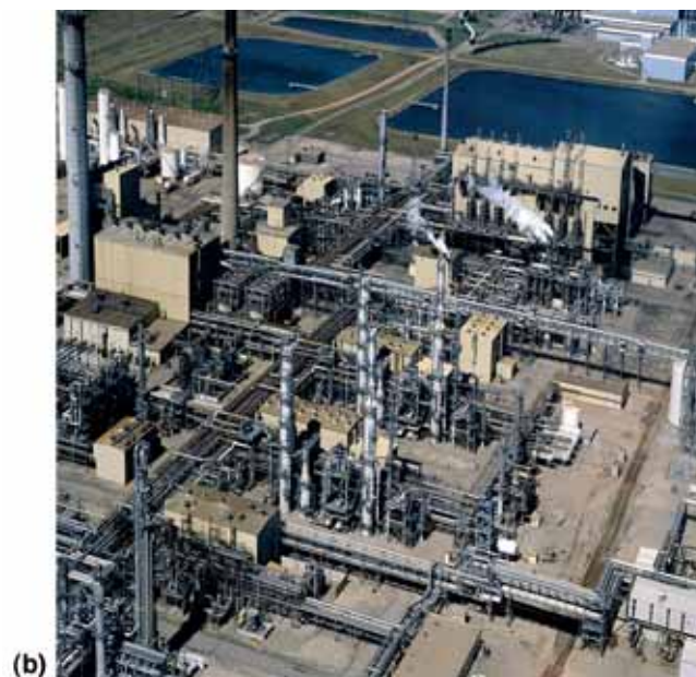
Gráfico RT-4. a) Captación de \text{CO}_2 posterior a la combustión en una planta de Malasia. Esta planta utiliza un proceso de absorción química para separar 0,2 Mt de \text{CO}_2 al año del flujo de gas de combustión de una central eléctrica alimentada por gas para la producción de urea. (Por gentileza de Mitsubishi Heavy Industries). b) Captación de \text{CO}_2 previa a la combustión en una planta de gasificación de carbón en Dakota del Norte, Estados Unidos. Esta planta utiliza un proceso de solvente físico para separar 3,3 Mt de \text{CO}_2 al año de un flujo de gas para producir gas natural sintético. Parte del \text{CO}_2 captado se utiliza para un proyecto de recuperación mejorada de petróleo en Canadá.
